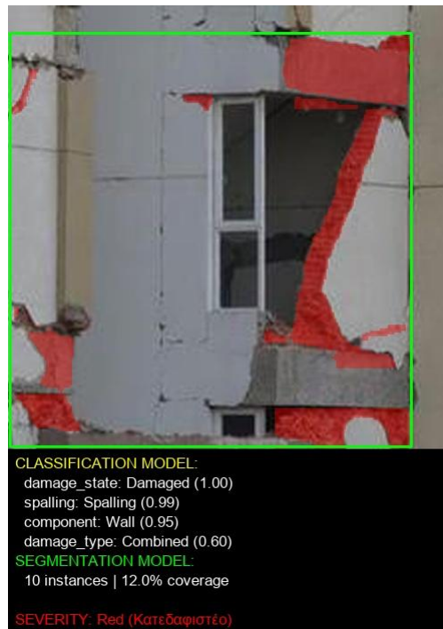
Εικόνα 18. Spalling override: Wall, Combined, κάλυψη 12,0%.
