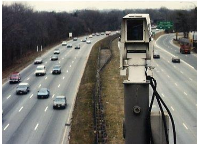
Figure 2 ΚΑΜΕΡΑ ΕΠΙΤΗΡΗΣΗΣ ΚΥΚΛΟΦΟΡΙΑΣ
